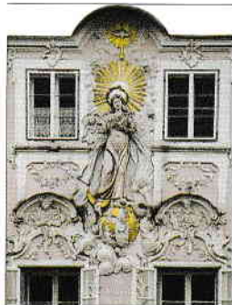
Detaliu de pe fațada unei farmacii din Obernberg in Austria Superioară
